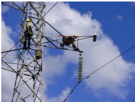
Fig. 11. Instalação do sistema de medição do ângulo de balanço.
